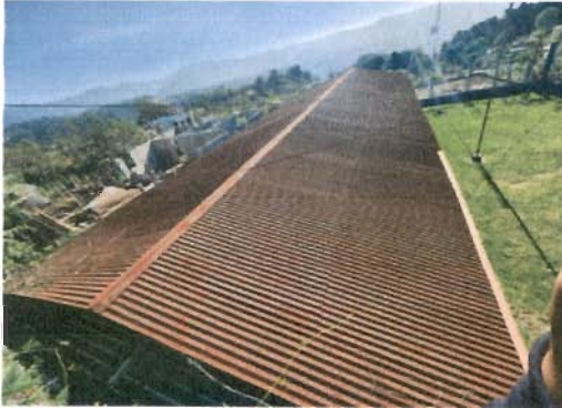
Foto 1: Sustitución de lámina por lámina troquelada aluzinc calibre 26 y sustitución de capote en módulo 1
