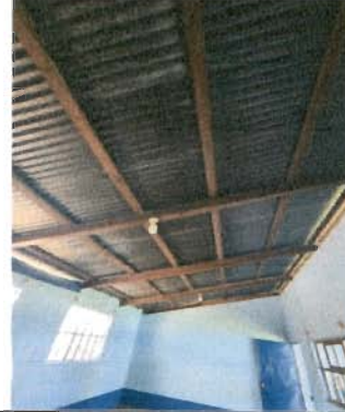
Foto 2: Sustitución de estructura de soporte de madera por metal (en aulas 1 y 2) en módulo 1
