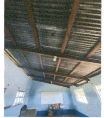
Foto 2: Sustitución de estructura de soporte de madera por metal (en aulas 1 y 2) en módulo 1
