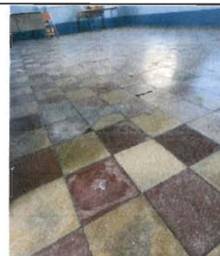
Foto 8: Sustitución de piso de granito por cerámico (en aulas 1 y 2) en módulo 1
