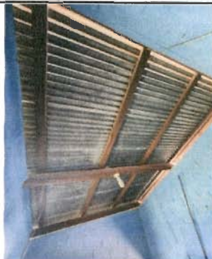
Foto 3: Sustitución de estructura de soporte de madera por metal (en cocina y dirección) en módulo 1
