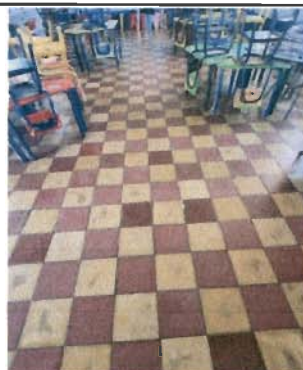
Foto 8: Sustitución de piso de granito por cerámico (en aulas 1 y 2) en módulo 1
