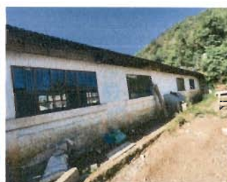
Foto 11: Sustitución de canales de pvc y bajadas de agua pluvial en módulo 1
