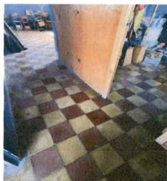
Foto 9: Sustitución de piso de granito por cerámico (en cocina y dirección) en módulo 1
