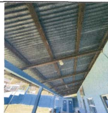
Foto 4: Sustitución de estructura de soporte de madera por metal (en corredor) en módulo 1
