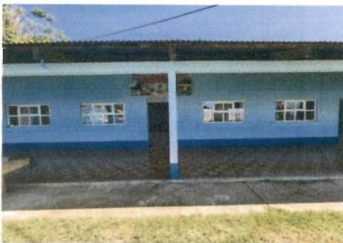
Foto 5: Sustitución de ventanas de madera por PVC en módulo 1
