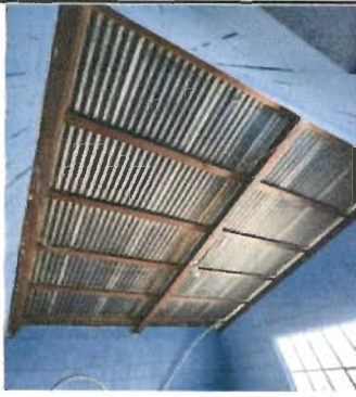
Foto 3: Sustitución de estructura de soporte de madera por metal (en cocina y dirección) en módulo 1
