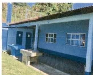
Foto 11: Sustitución de canales de pvc y bajadas de agua pluvial en módulo 1
