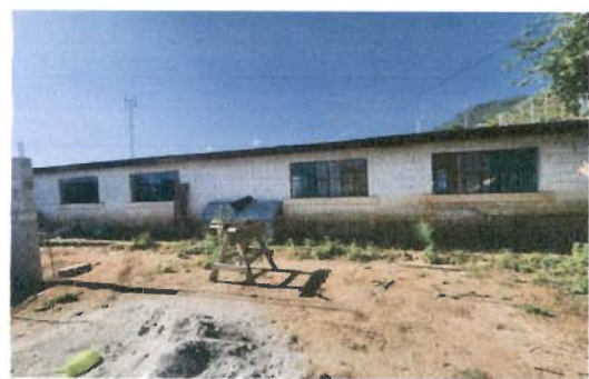
Foto 6: Sustitución de ventanas de madera por PVC en módulo 1
